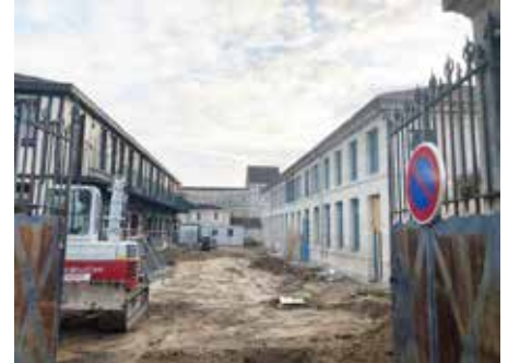
Der Komplex „Paul Bert“ zu Beginn des Umbaus im Jahre 2020
