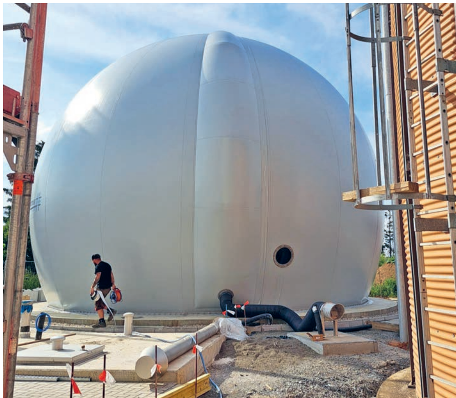
Doppelmembranspeicher: Die Außenmembrane bildet die eigentliche Schutzkonstruktion und befindet sich immer unter einem für die Statik erforderlichen Überdruck. Den eigentlich nutzbaren Speicher bildet die Innenmembrane. Diese Membrane bewegt sich je nach Füllgrad nach oben oder unten.
