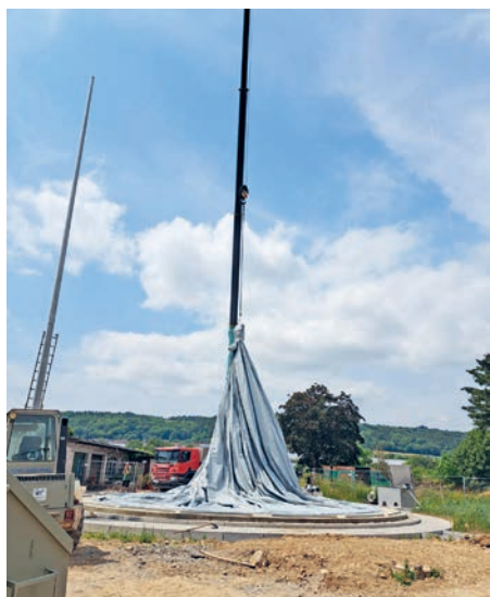
Eine Bodenmembrane dichtet den Speicherraum gegenüber dem Betonfundament ab.
