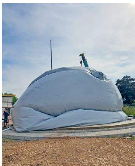
Eine Bodenmembrane dichtet den Speicherraum gegenüber dem Betonfundament ab.
